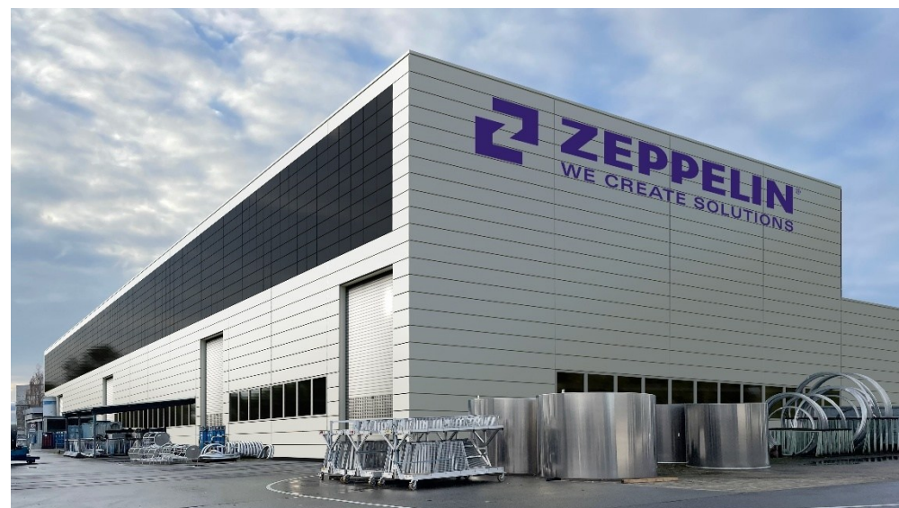
Ludwig-Dürr-Produktionshalle in Friedrichshafen: Fassadenintegrierte Photovoltaikanlage mit 1.280 Glas-Glas-Modulen trägt zur energieeffizienten Gebäudehülle bei und unterstützt die Eigenstromversorgung des Anlagenbau-Standorts von Zeppelin System
