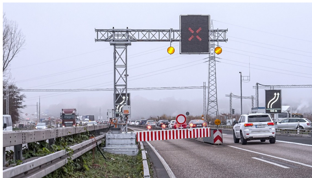
Intelligente Wechselverkehrsführung von Zeppelin Rental: Digital gesteuerte Verkehrslenkung reduziert Staus und senkt CO 2 -Emissionen auf Baustellen
